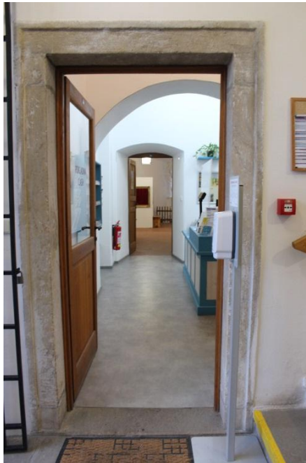
Foto 4 – vchod na pokladnu
