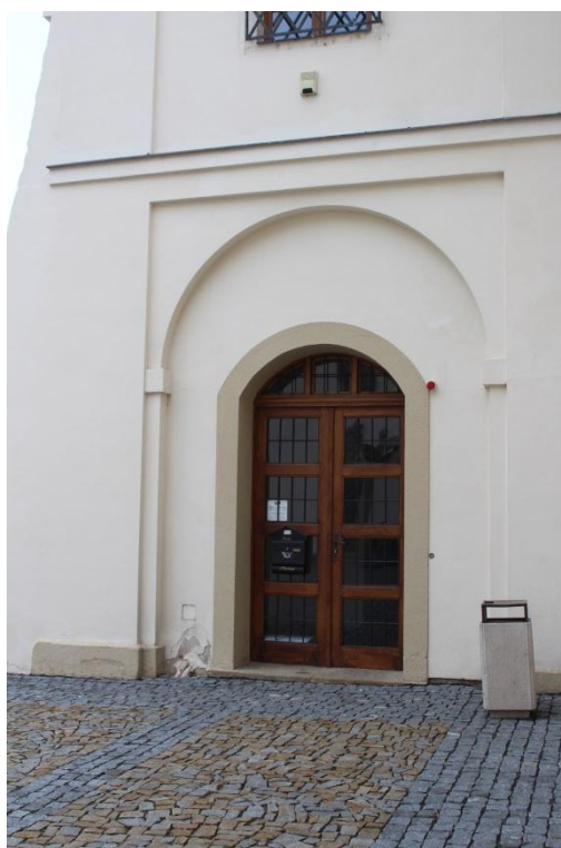
Foto 13 – vchod z nádvoří
