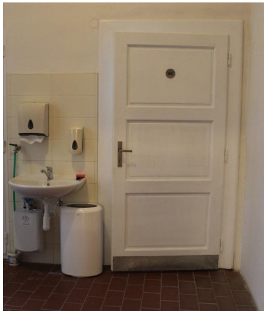
Foto 12 – vstup z chodby na WC
