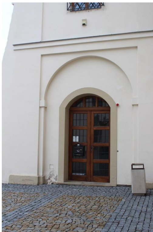
Foto 13 – vchod z nádvoří
